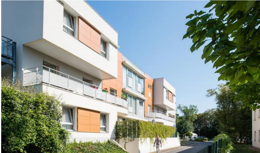
Ehpad Korian Le Petit Castel - Chambray-lès-Tours - França
